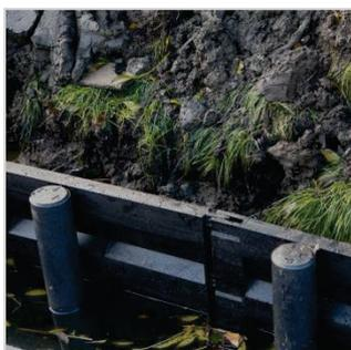
Grâce à l'assemblage unique et ultra-résistant des panneaux, il n'est pas nécessaire de placer les poteaux précisément au point d'assemblage des panneaux. Ceci permet d'obtenir un gain de temps significatif mais également une économie de coûts puisque les poteaux et les panneaux peuvent être installés séparément en une seule fois. Grâce à leur grande rigidité, les panneaux peuvent même être enfoncé dans le sol à l'aide d' un engin de terrassement..
