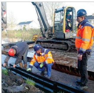
Le Système KLP® RapidRetain est une solution durable pour vos murs de soutènement! Le plastique KLP® est une excellente alternative la ou toutes les espèces de bois sont les plus vulnérables à la decomposition, plus précisément ou ils sont exposés à l'air et à l'eau. Le système de bords de berges ou murs de soutènement KLP® combine des panneaux KLP® RapidRetain et des poteaux KLP® combi-post (bois/plastique).
