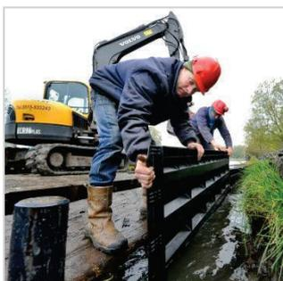
Tous nos produits KLP sont fabriqués à partir de plastique recyclé . Les déchets tels que capsules de bouteilles ou encore bâches agricole, retrouvent ainsi une nouvelle et longue vie en tant que panneau ou poteau KLP. De plus, ce matériau est imperméable et imputrescible. La durée de vie technique minimale de nos produits en plastique est de 50 ans et ils ne nécessitent aucun entretien.
